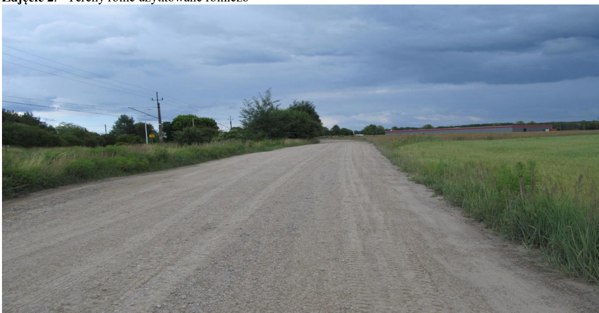
Zdjęcie 3. Teren drogi gruntowej w części północnej
