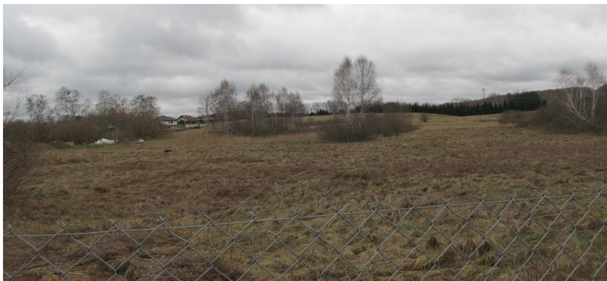
Zdjęcie 6. System rowów melioracyjnych odwadniająca północną część terenu opracowania
