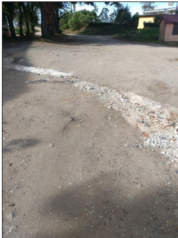
Zdjęcie 22. Teren drogi oznaczonej symbolem 2KDW (na odcinku pomiędzy terenami oznaczonymi symbolami 1UMN i 3UMN).
