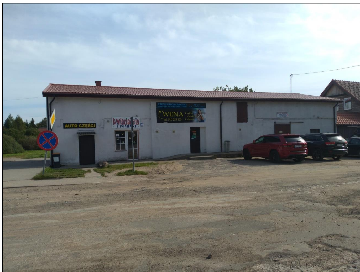
Zdjęcie 12. Istniejąca zabudowa na terenie oznaczonym symbolem 3U; droga 2KDZ.
