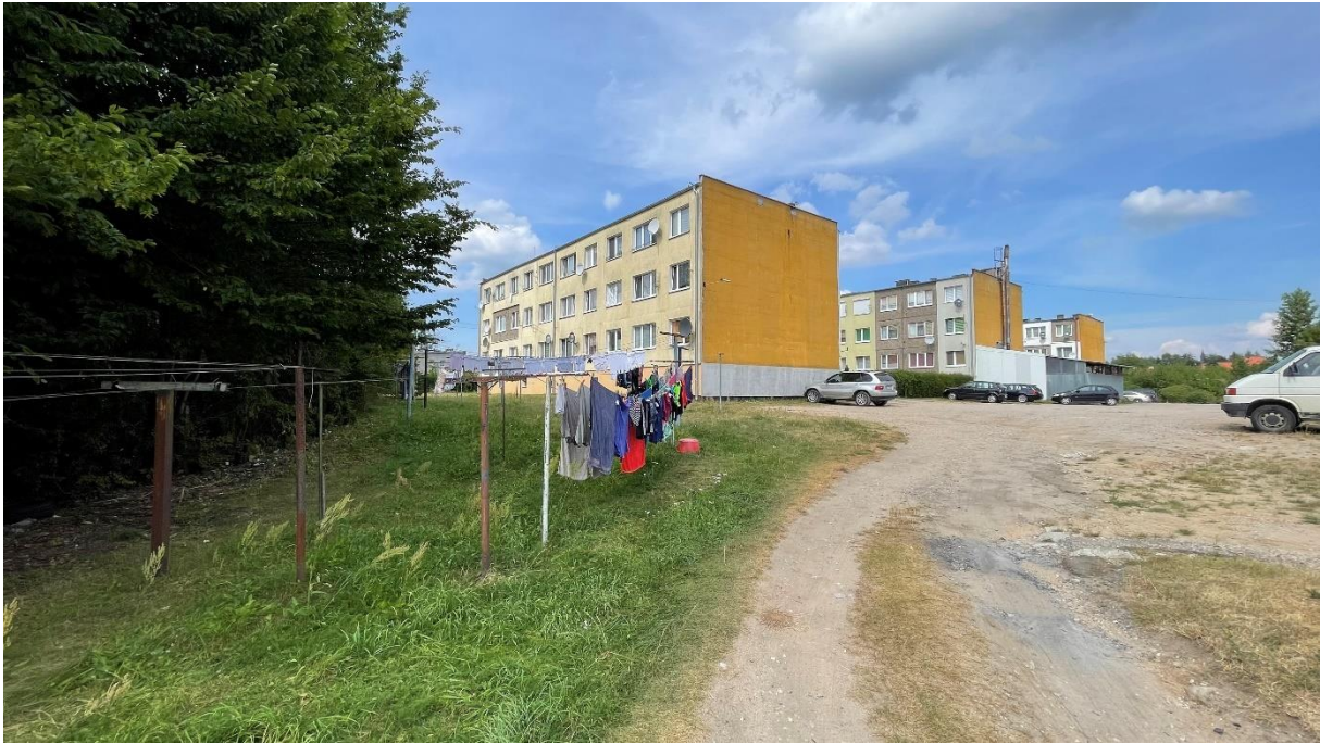
Zdjęcie 19 Widok na sąsiadującą zabudowę wielorodzinną
